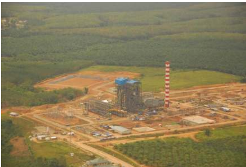
Pemandangan area konstruksi pembangkit listrik mulut tambang berkapasitas 2X30 MW dari udara (Juli 2011)
