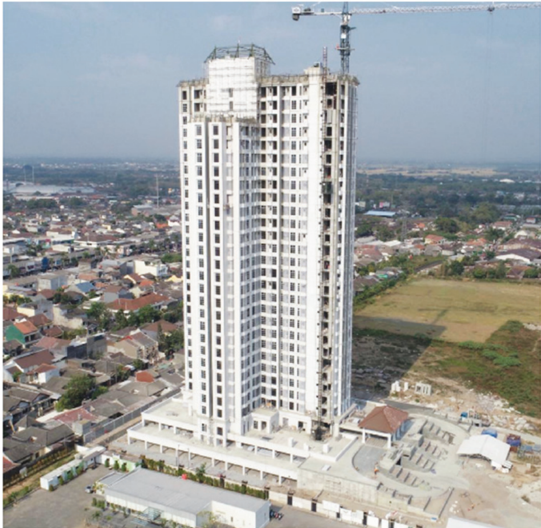
Progres terakhir perkembangan Apartemen Apsara tahap 1 Sumber: Perseroan, akhir Agustus 2018
